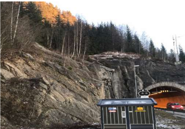
Fig 11b E16-tunnellen har boret seg inn i kambrosiluren (se skråstilt skifer i forgrunnen), - lavadekket ligger i sollyset øverst på bildet.
